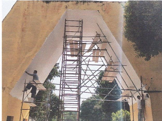
**34.** Se realizó mejoramiento de infraestructura de 1techo con estructura metálica con 15 tubos de 6x4 pulgadas, 7tubos de 4x4 pulgadas y costanera de 3x2 pulgadas, 85 láminas de 12 pies y 800 tornillo polser de 1 ½" para parqueo de buses.
