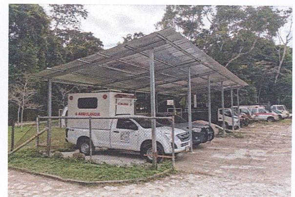
**39.** Se realizó el mejoramiento de infraestructura de techo con estructura metálica con 20 tubos de 4x4 pulgadas, 36 costanera de 3x2 pulgadas, láminas de 12 pies y 950 tornillo polser de 2pulgadas para parqueo de automóviles frente a bungalós.
