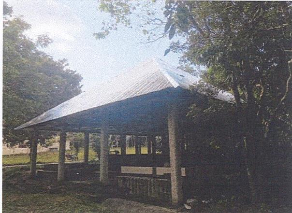
**38.** Se realizó mejoramiento de infraestructura de 1 techo con estructura metálica con 18 tubos de 4x4 pulgadas, 25 costanera de 3x2 pulgadas, láminas de 12 pies y 900 tornillo polser de 1 ½" para parqueo de automóviles frente a unidad de transportes.
